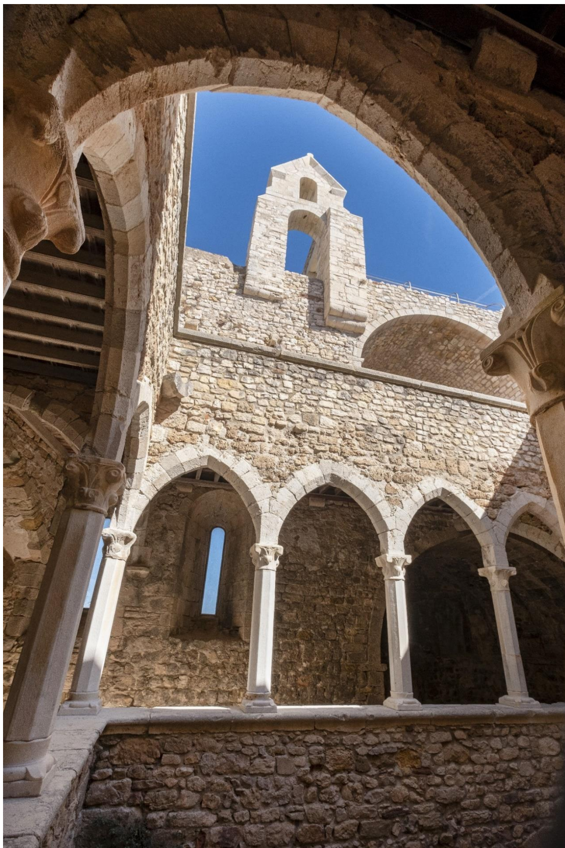
CLOÎTRE SUPÉRIEUR ET LE NIVEAU AU-DESSUS AVEC LE CLOCHER, © HUGUES LAGARDE
